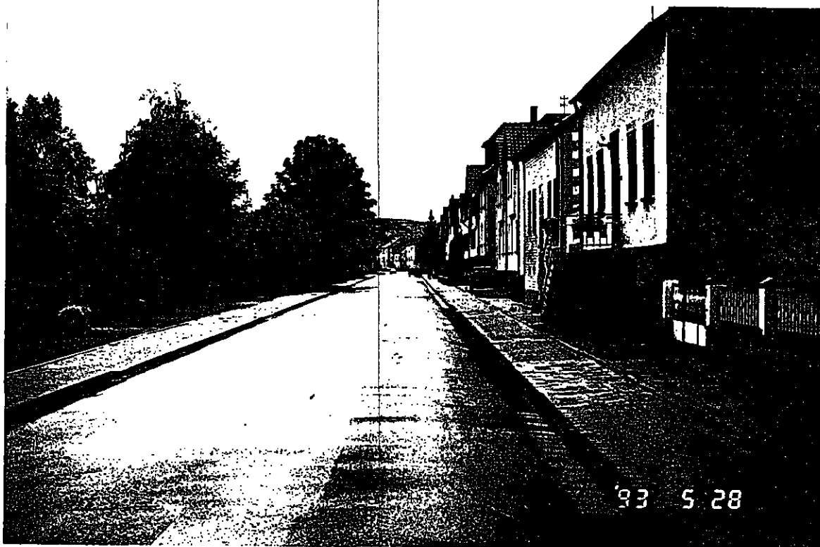
Mittlerer Teil der Jabacher Straße
