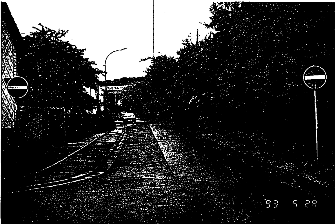
Einmündung Kapellenstraße/Jabacher Straße
